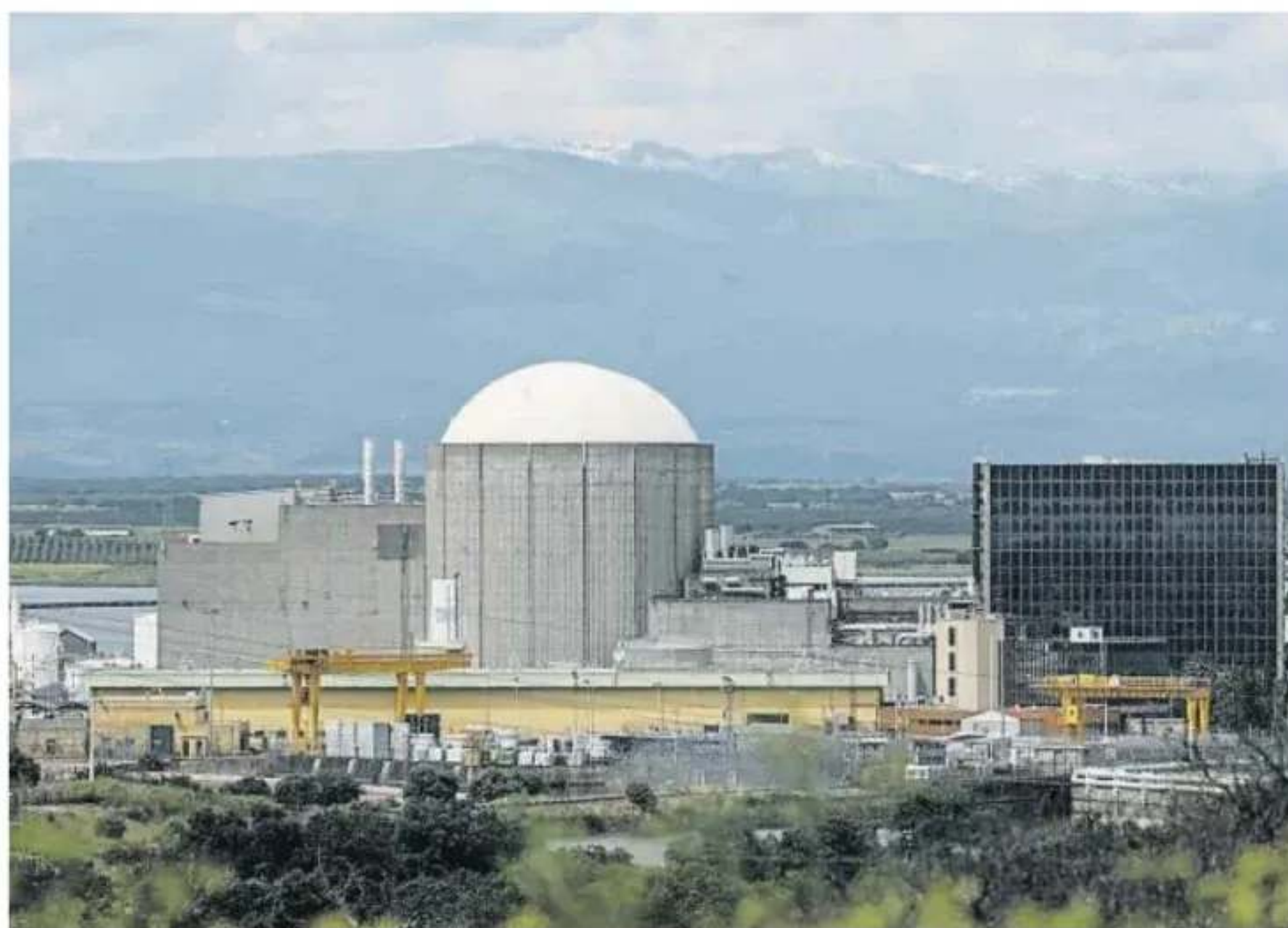
Central nuclear de Almaraz, en Extremadura
