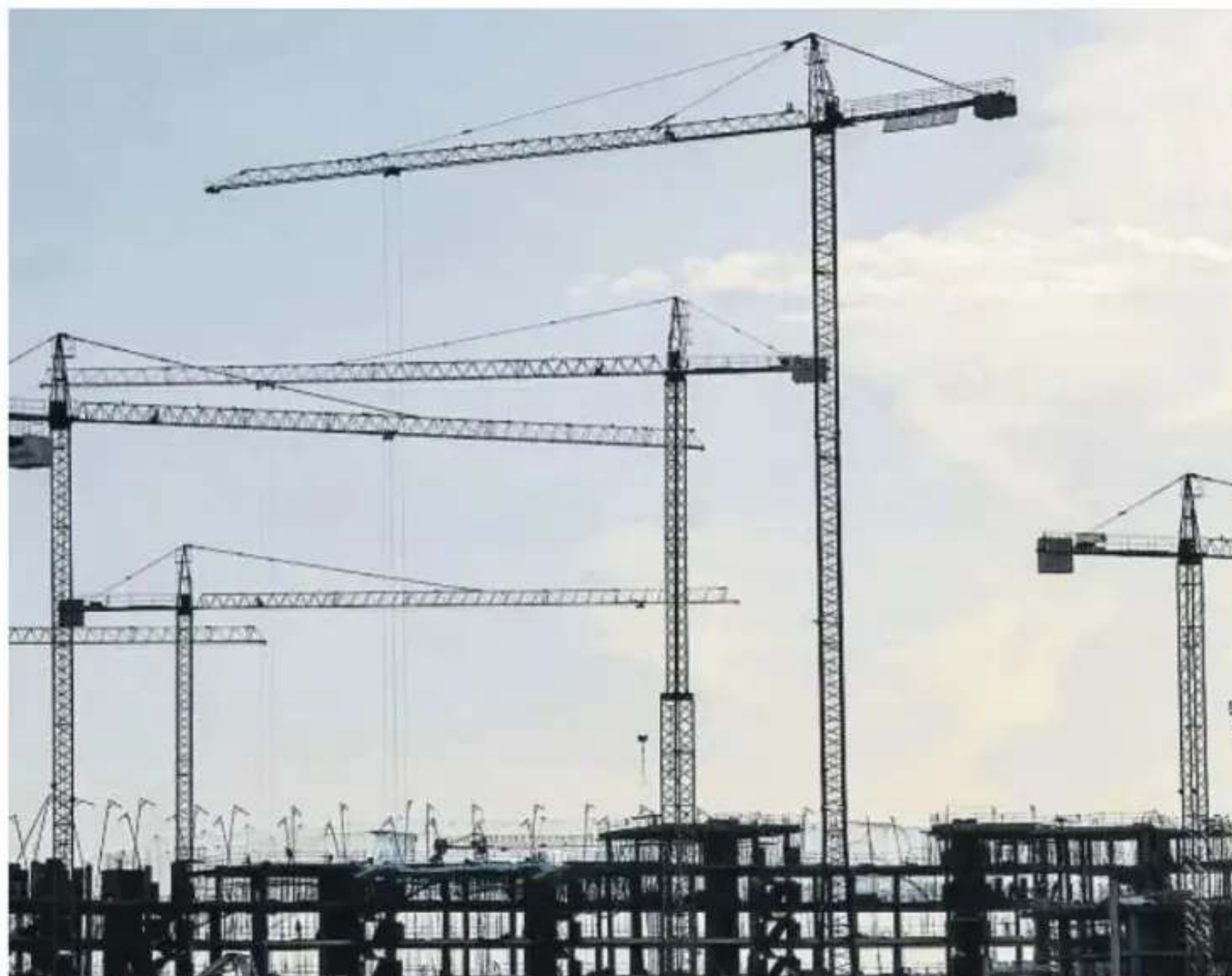
Construcción de viviendas en Dos Hermanas, en Sevilla
